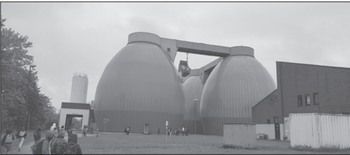
Die Kläranlage Barbing mit den drei großen Faultürmen
